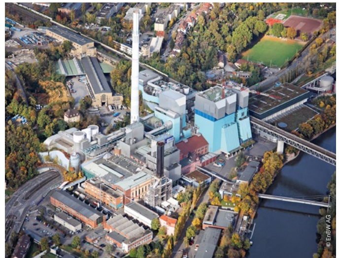
Gas- und Dampfkraftwerk in Stuttgart-Münster.
